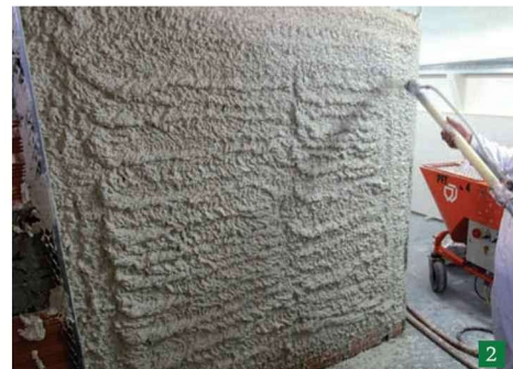
Projection de l'enduit de plâtre
