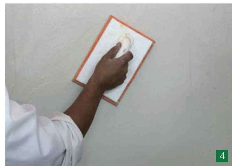
Frotasse à la taloche en mousse
